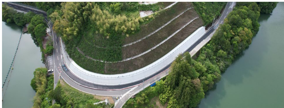
道路改良工事
